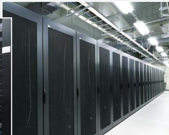
千葉县的数据中心凭借“抗震设计”+“减震机柜”，即使在震度5弱的情况下也没有发生故障。
